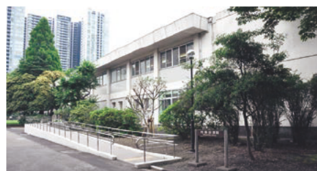
附属図書館（本館） University Library (Main Library)
