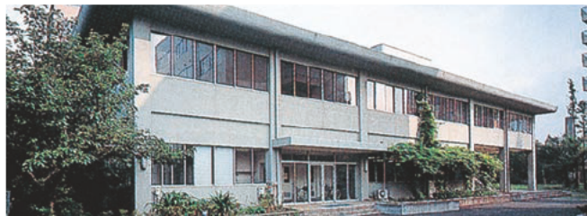
附属図書館越中島分館 Etchujima Branch Library
